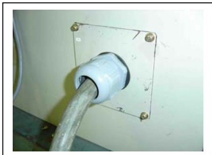
Fig. G.2.1 (b) Fitting a conduit
